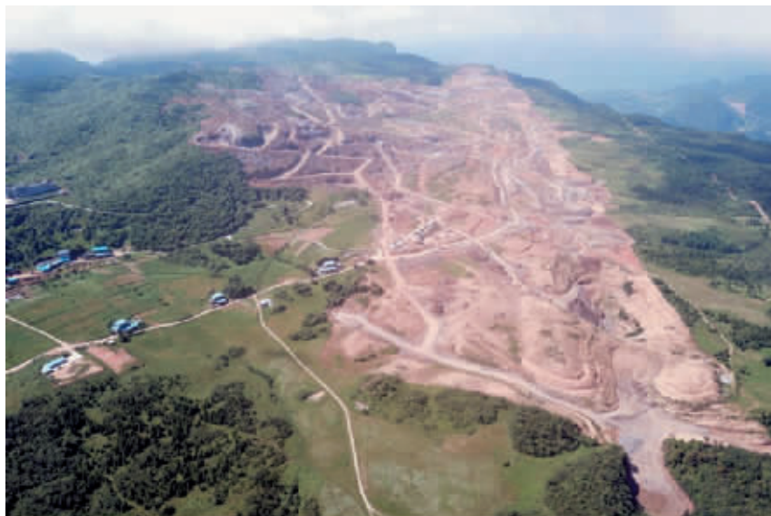
建设中的武隆机场
